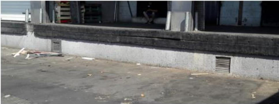
Figure 10 : grilles de dispersion (dimensions 42 cm x 42 cm) sous les quais de déchargement
