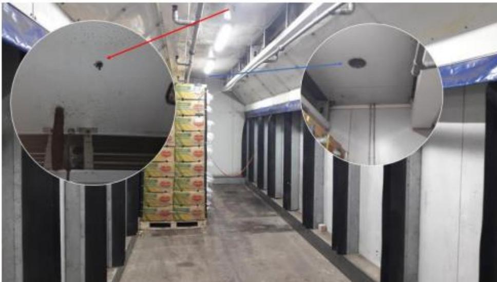
Figure 6 : position de l'injection d'Azéthyl (flèche rouge) et de l'extraction (flèche bleue)
